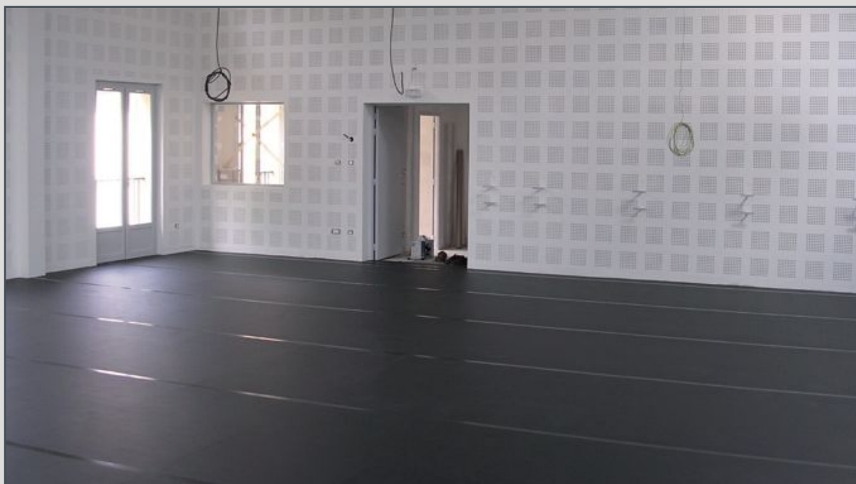
Construction d'un studio : plancher Saltis + tapis de danse (Rambouillet).
